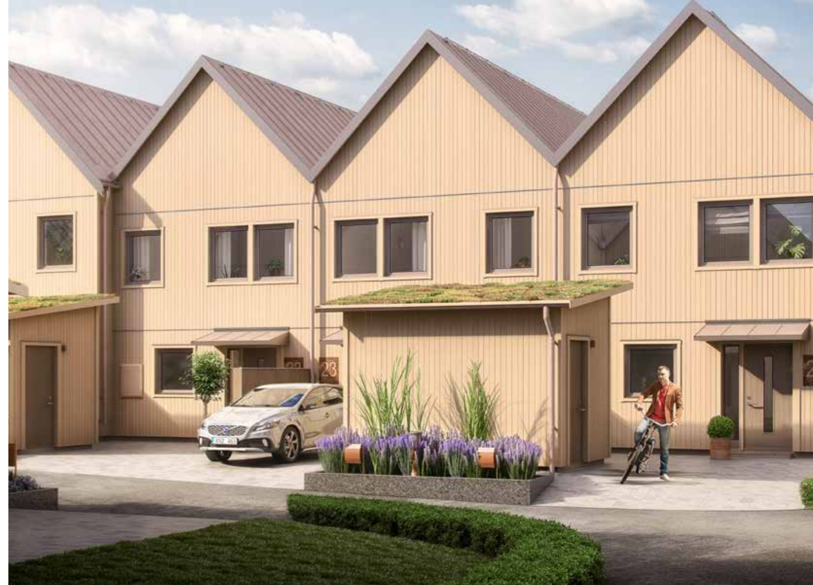
I Brf Dansbandet 2 i Norrköping har OBOS byggt stadsradhus i trä, och tillhörande förrådsbyggnader med sedumtak.
